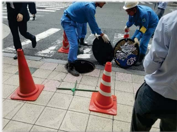
新しいマンホール蓋に当社社員が取替中！
